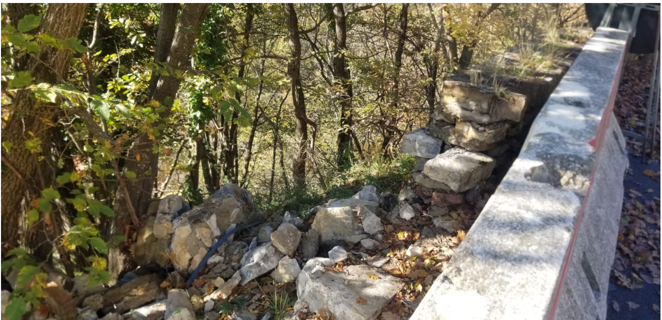
km 5+200 – intervento in programma: realizzazione nuovo cordolo semplice in c.a. e installazione nuovo dispositivo di ritenuta stradale.
