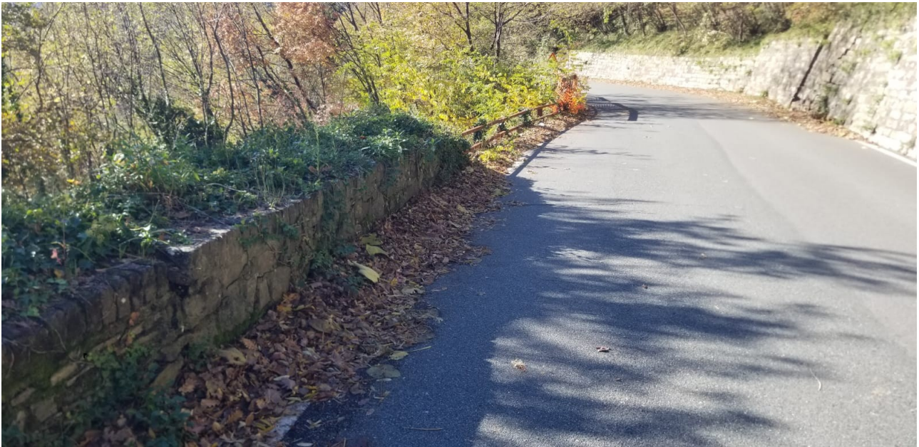
km 3+900 – intervento in programma: rimozione muro e ringhiera, nuovo cordolo semplice in c.a. e installazione nuovo dispositivo di ritenuta stradale.
