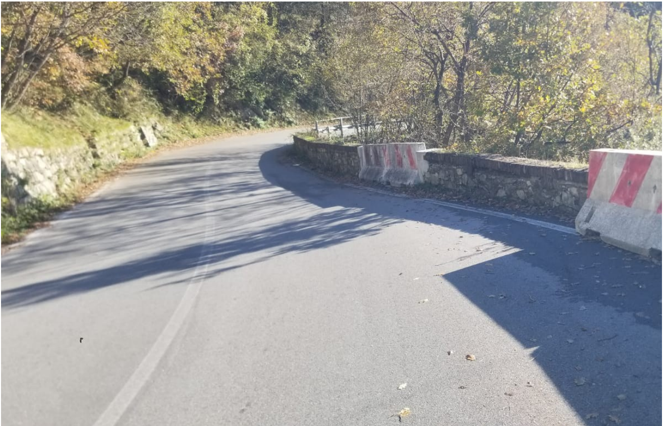
km 5+200 – intervento in programma: realizzazione nuovo cordolo semplice in c.a. e installazione nuovo dispositivo di ritenuta stradale.
