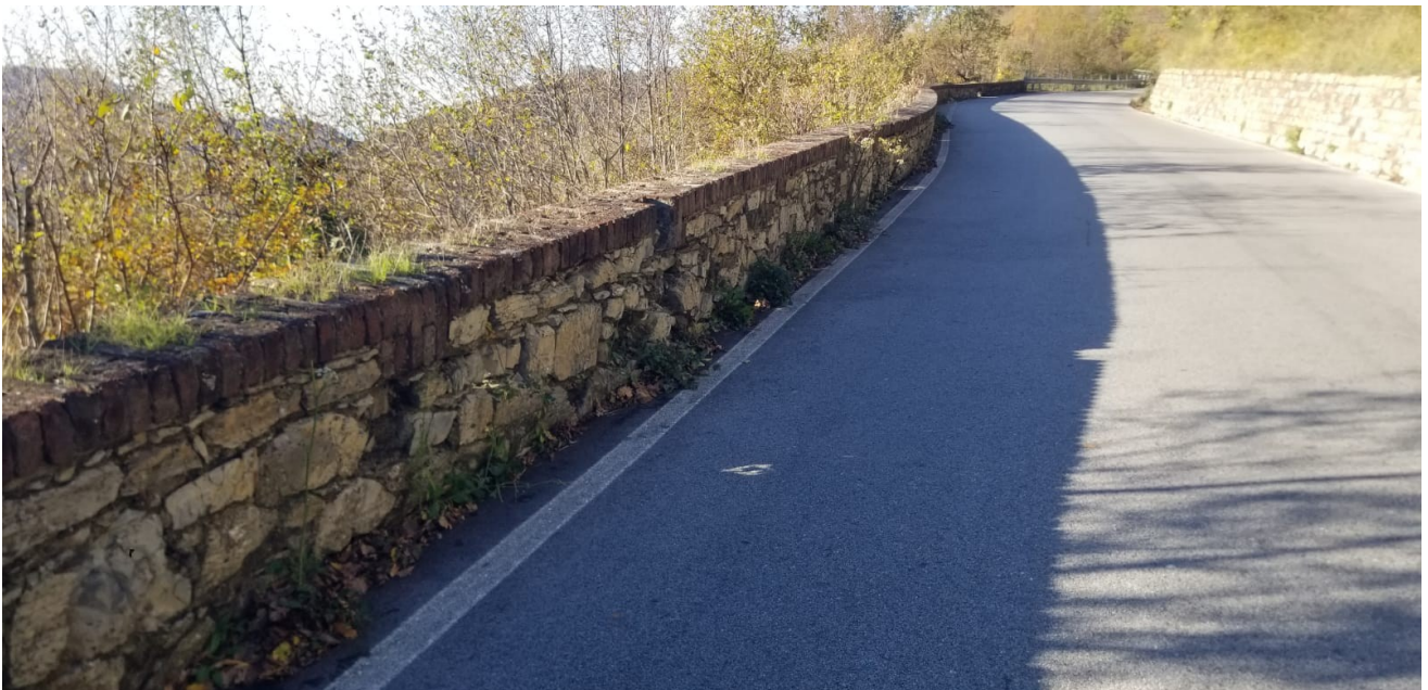
km 4+400 – intervento in programma: demolizione muretto esistente, nuovo cordolo semplice in c.a. e installazione nuovo dispositivo di ritenuta stradale.
